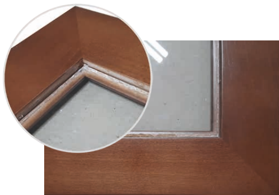
Простая вклейка (На фото тыльная сторона фасада)
